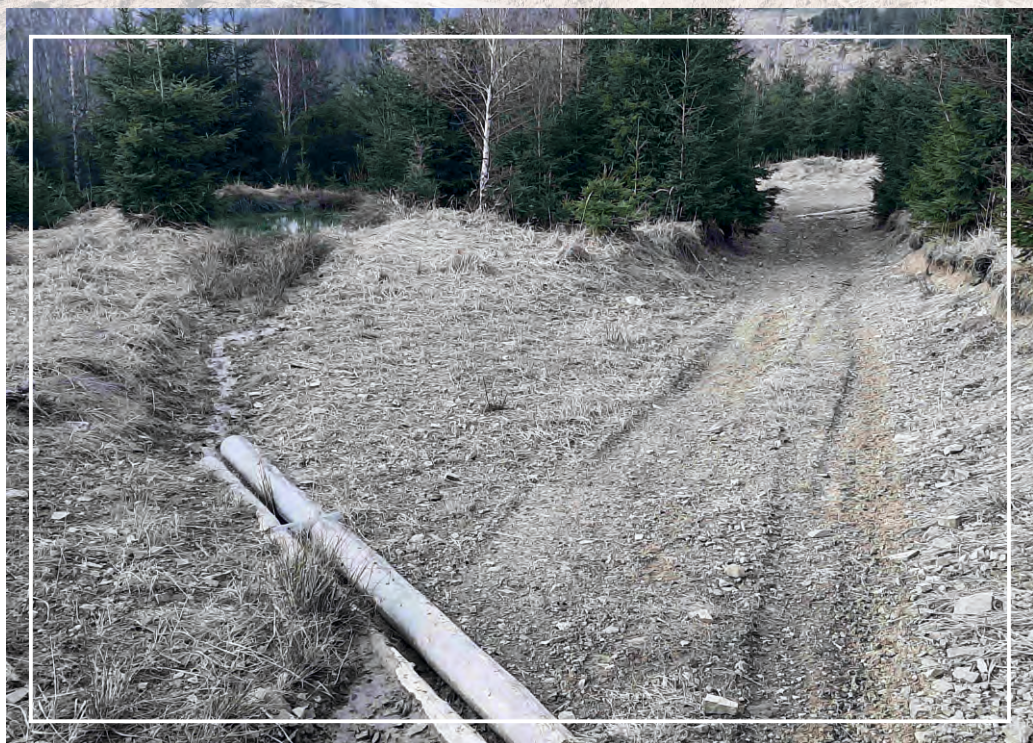
Ukážka proti eróznej odrážky s nádržou na zachytenie vody.
